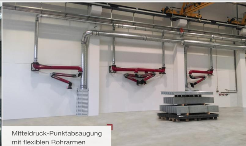
Mitteldruck-Punktabsaugung mit flexiblen Rohrarmen
